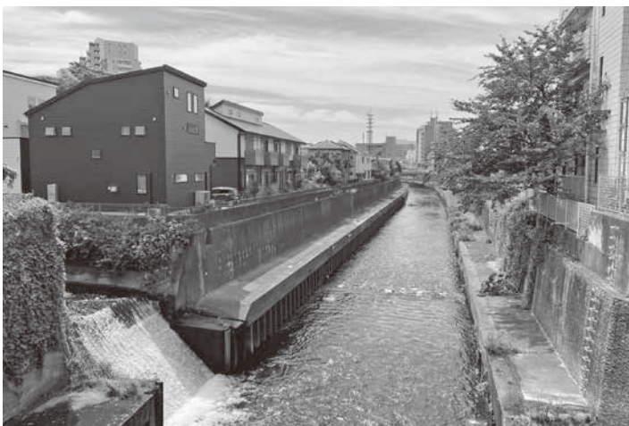
写真4 現在の藤沢橋から川岸を望む
