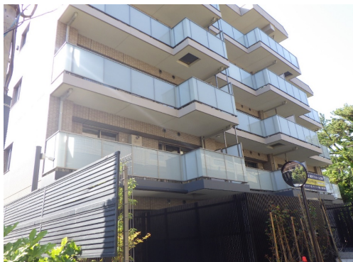
【マンション全景】
