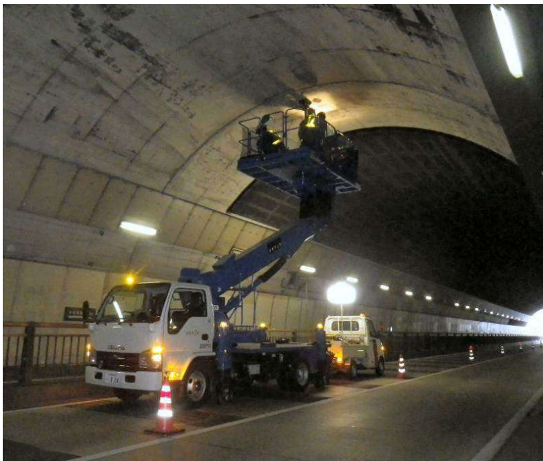
定期点検状況(大庭トンネル)
