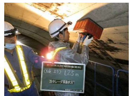
覆工背面空洞探査状況
