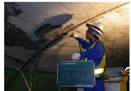
近接目視・打音検査状況
