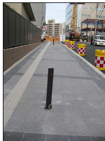
遊行寺参道敷石をモチーフとした平板ブロック舗装・ポラード(車止め)設置状況
