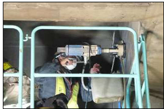
コンクリートコア採取状況
