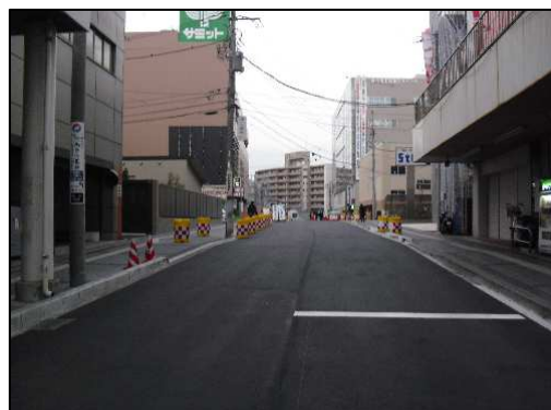
北口通り線(舗装工事完成後)
