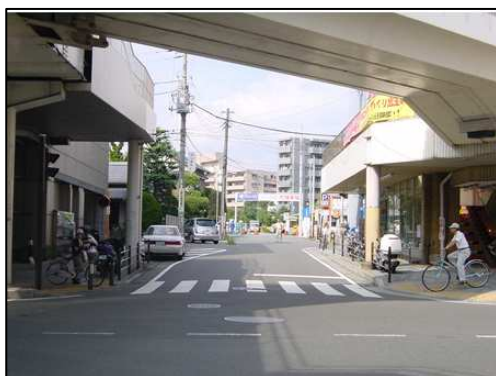
北口通り線(着手前)
