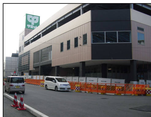
建設工事中の商業施設
