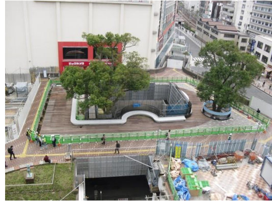
ビックカメラ前の完成したベンチ
