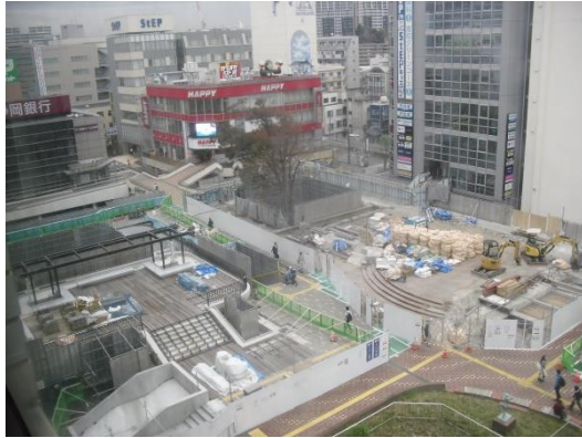
サンパールビルから見た施工状況
