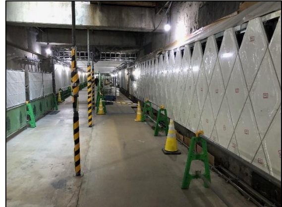
通路部壁面パネルの施工
