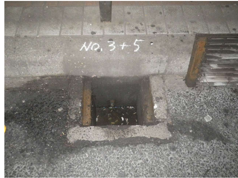
既設排水柵 確認状況 (1)
