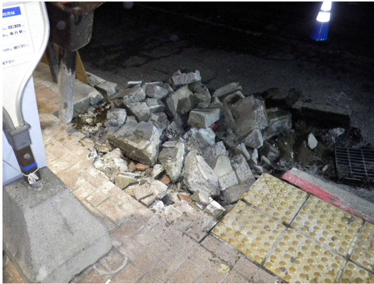
歩道タイル舗装 撤去状況 (1)
