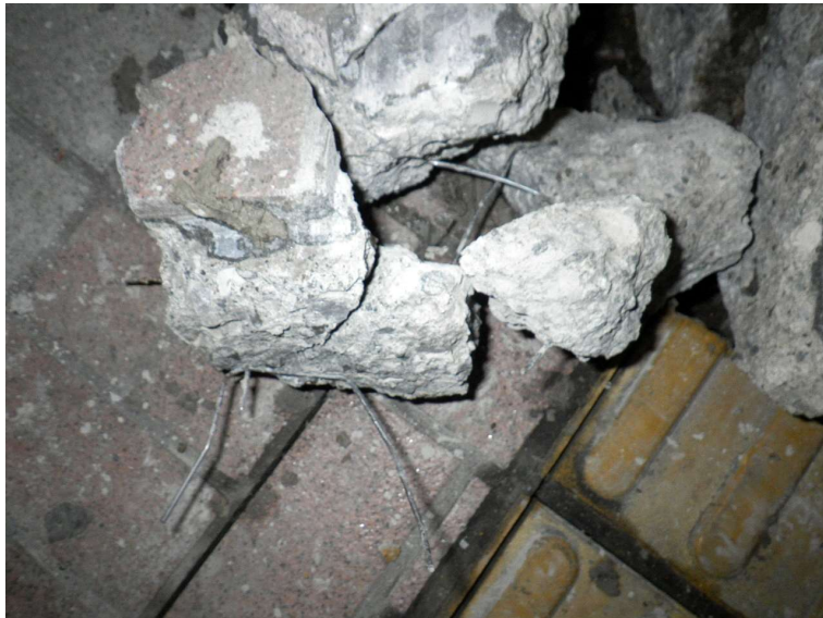
歩道タイル舗装 撤去状況 (2)
