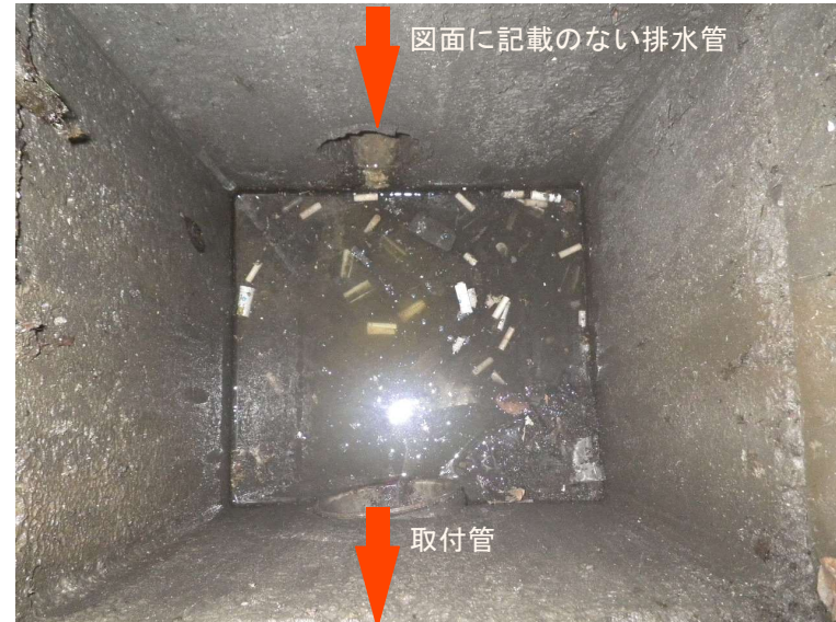
既設排水柵 確認状況 (2)
