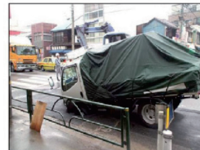
道路陥没の例 (東京都墨田区) (国土交通省資料)
