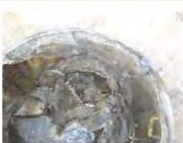
マンホールと管渠の接合部破損
