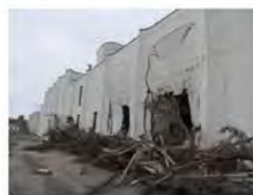
津波漂流物による建物への直接被害
