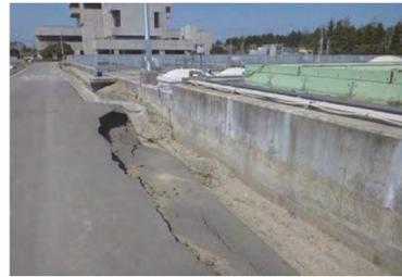
浄化センターでの路面陥没
