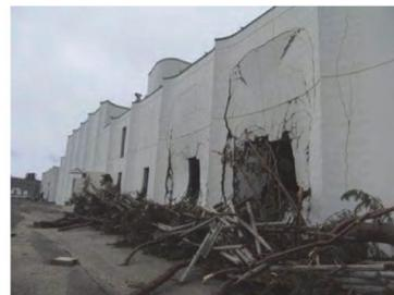
津波漂流物による建物への直接被害
