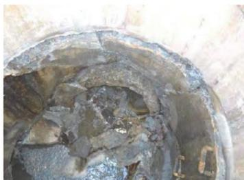
マンホールと管渠の接合部破損
