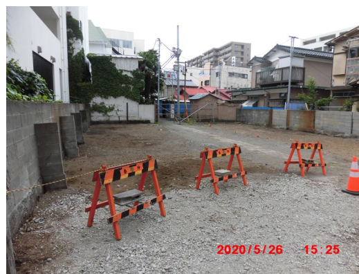
解体後の敷地
