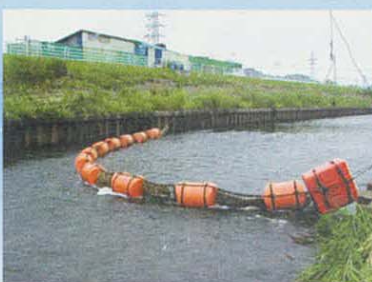
←河川除塵機(境川) 上流から流れてくるごみが海に流出しないように取り除いています。 (引地川と境川に設置)
