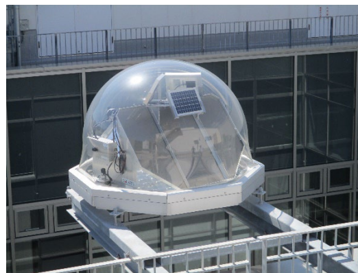
◆藤沢市役所屋上の集光器
