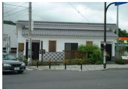
◆自動車排出ガス測定局（藤沢橋）
