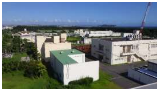
【辻堂浄化センター】
