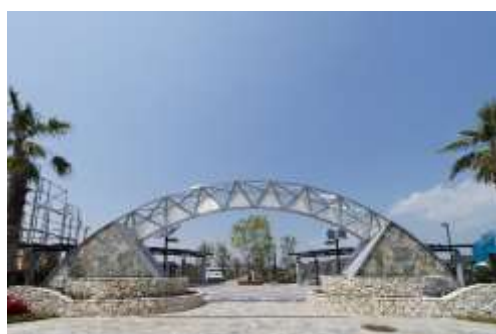
(写真) Fujisawa SST 協議会提供 【正門】
