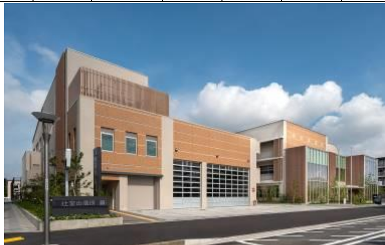
令和3年8月6日に新築移転した辻堂出張所
