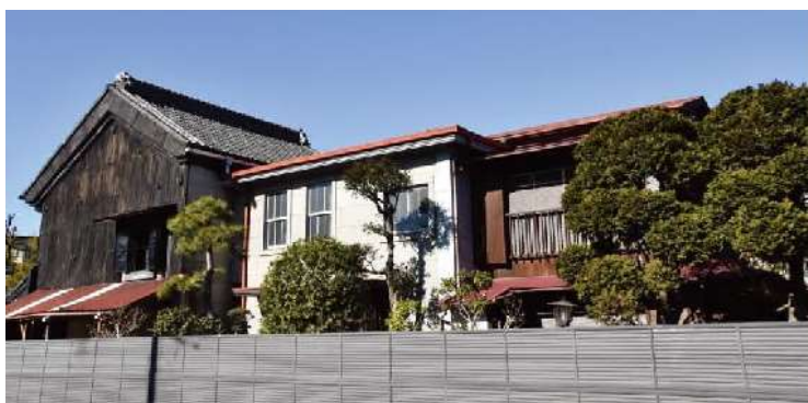
主屋 東側外観
