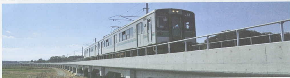
内陸部に移設した坂元駅付近を走行するJR常磐線の車両
