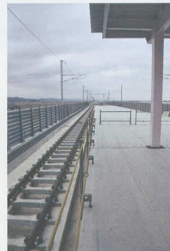
JR新山下駅の真新しいホームと線路
