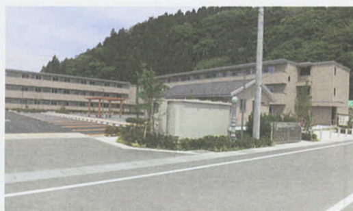
6月1日 切通地区住宅D工区で入居開始(気仙沼市) ※写真は気仙沼市提供
