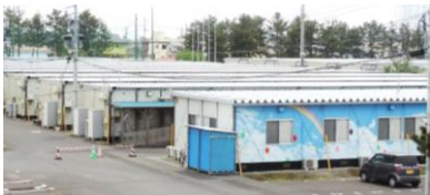
▲仮設住宅（東松島市）
