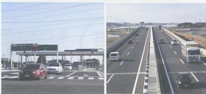
写真出典：仙台河川国道事務所
