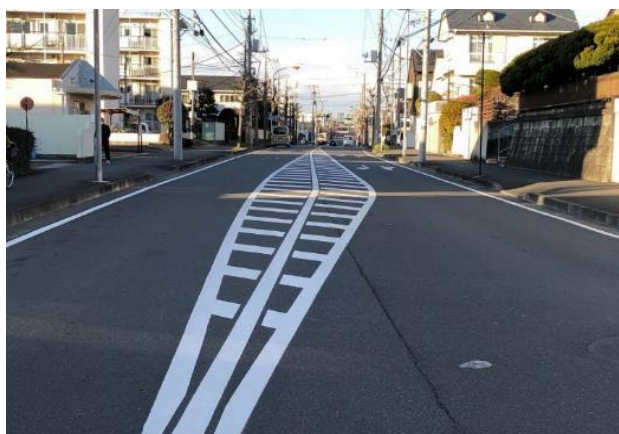
道路区画線標示施工例
