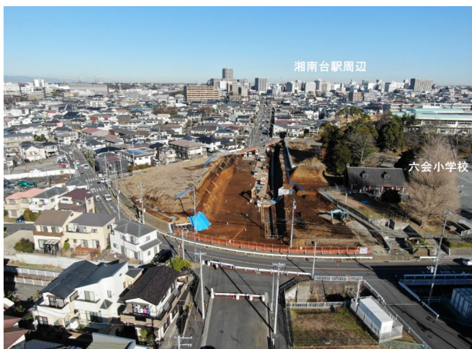
進捗状況写真（六会側から湘南台方面を望む）
