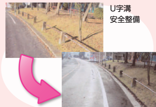
十二天公園東側を中心にU字溝のコンクリート蓋を撤去し、段差を解消。路側帯の有効幅が約40cm程度確保。
