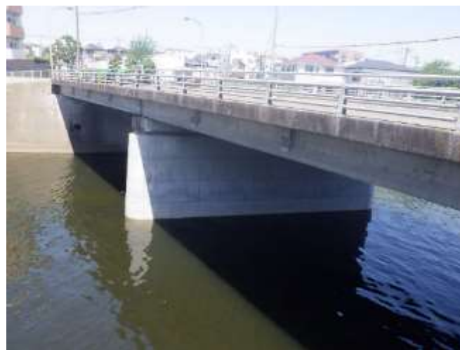
耐震化を実施した新屋敷橋
