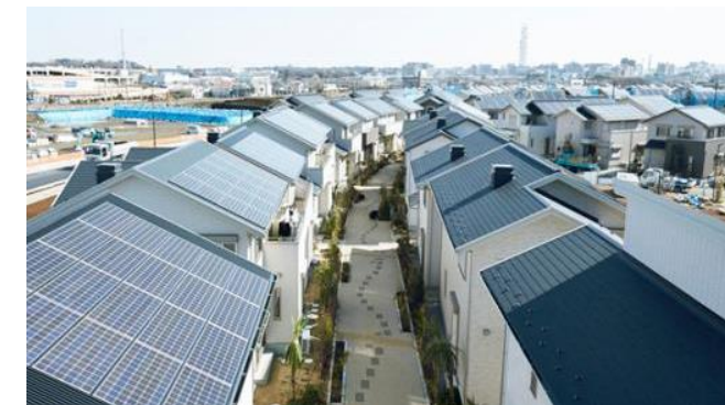
太陽光パネルがならぶ街並み (Fujisawa SST HP より)
