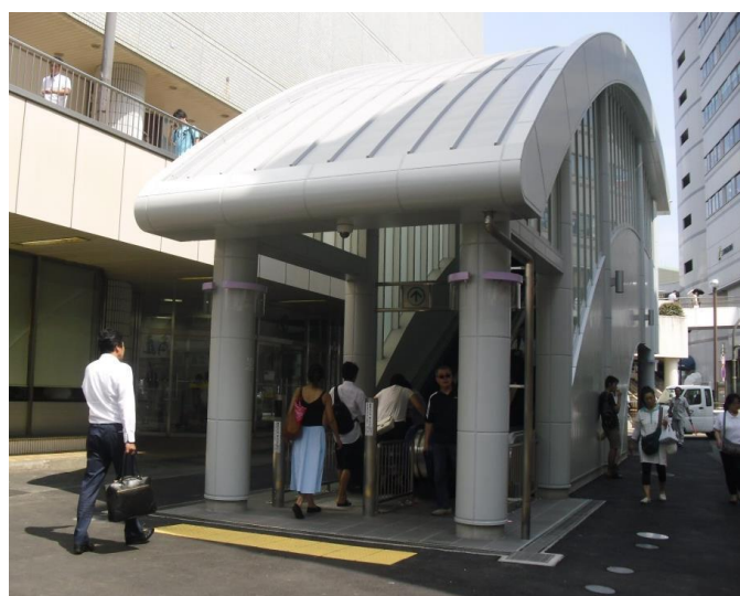
藤沢駅北口エスカレーター設置
