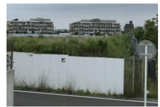
北東側から見える敷地内の様子 長大な鋼板の仮囲いで囲われている
