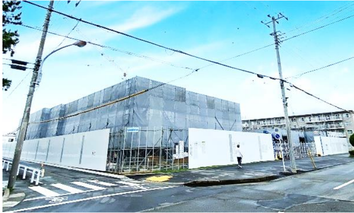
【7月現在の工事の状況（南東から）】
